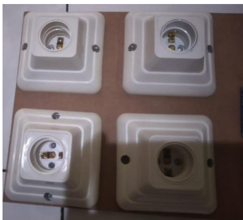
Gambar 8 Pemasangan Fitting Lampu
