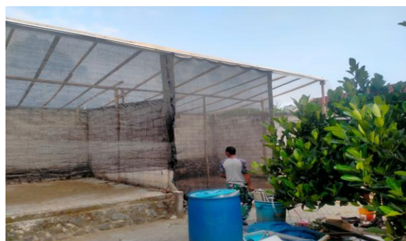
Gambar 2. Penyelesaian Pembangunan Tata Ruang Green House di Perkebunan Jeruk
