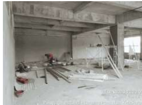
Gambar 2. Dokumentasi progres pekerjaan pemasangan pipa hydrant sprinkler lantai 2
