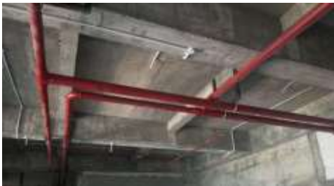
Gambar 7. Pemasangan Pipa Hydrant Utama pada Area Lobby Lift Sumber: Dokumentasi Pribadi
