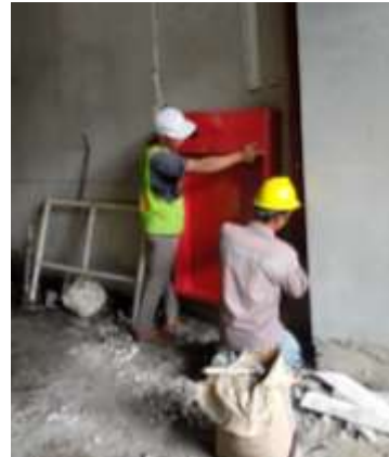
Gambar 3. Pemasangan Kotak Hydrant Sumber: Dokumentasi Pribadi
