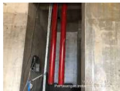
Gambar 4. Pipa Tegak dan Pipa Mendatar
