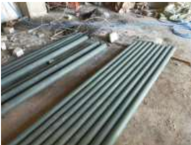
Gambar 2. Pelapisan Anti Karat dan Pengecatan Pipa Hydrant Sumber: Dokumentasi Pribadi
